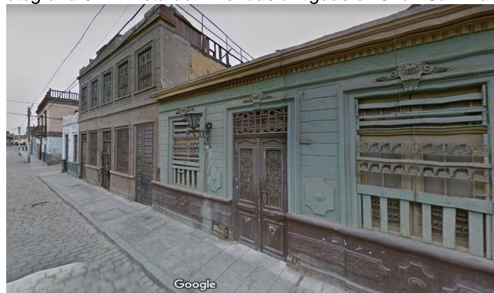
Fotografía 9 Vista de viviendas antiguas en Jirón San Martín
