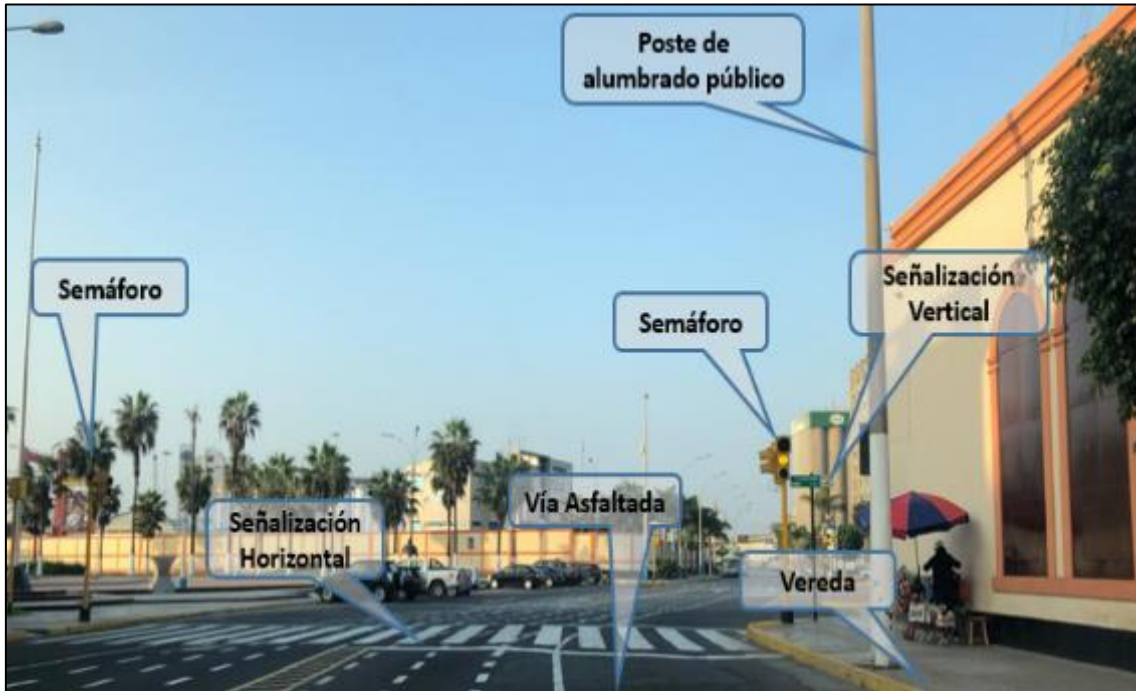
Fuente: Trabajos de campo / Elaboracion propia.
