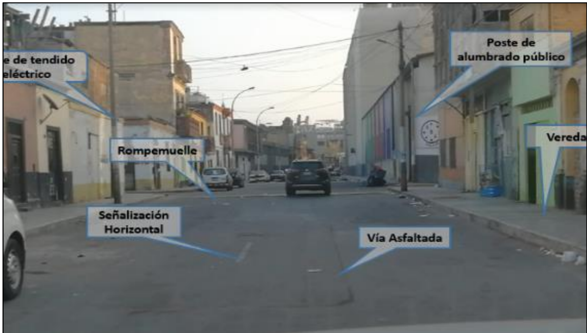
Grafica N° 15 - Infraestructura vial y mobiliario urbano en el Jr. Constitucion - Area de influencia indirecta.
