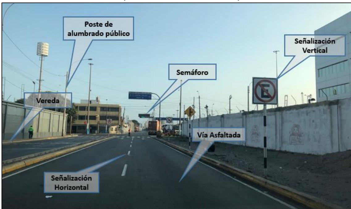
Fuente: Trabajos de campo / Elaboracion propia.
