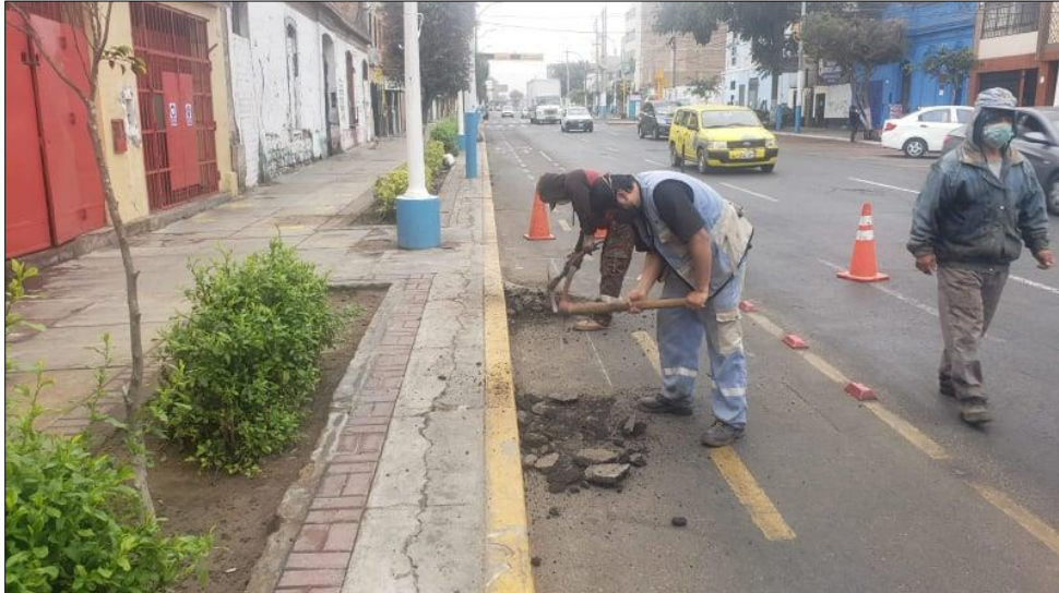
Grafica N° 19 – Ejecución de trabajos de bacheo en Ciclovías.
